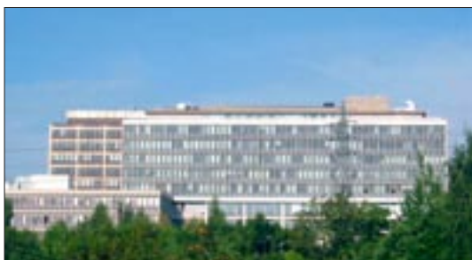
Vital Eiendom har mottatt prisen "Greenlight Award 2004" for deres solide totalplanlegging og utførelse av et nytt belysningsanlegg i kontorbygget i Lørenfallet 1, Oslo.
