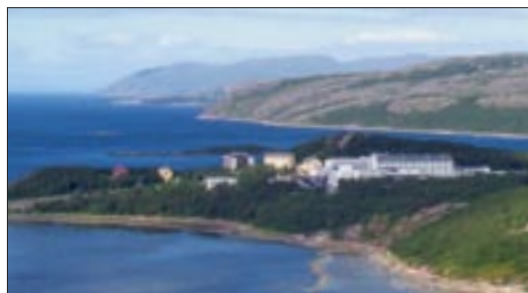
Kirkenes Sykehus har i 2003 utført en rekke tiltak for å redusere energibruken til oppvarming. Utskiftning av 200 manuelle radiatorkraner med termostatstyrte kranser og ny frekvensstyrt hovedpumpe i nytt fyrhus er blandt tiltakene som er gjennomført. I tillegg vurderer sykehuset sjøvannbasert varmepumpe.
