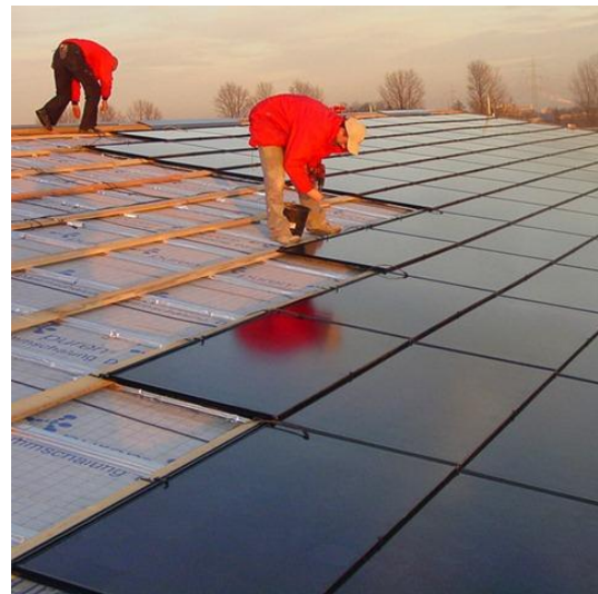
Figur 3.2: Paneler integrert i tak [Ernst Schweizer AG www.schweizer-metallbau.ch ]
