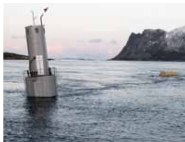
Morild II, verdens største flytende tidevannskraftverk (1,5 MW) er plassert i Gimsøystraumen i Lofoten. Hydra Tidal er teknologiutvikler og utbygger. Målet er å få bygget, testet, modifisert og demonstrert en prototyp av kraftverket i full skala. Forventet energileveranse er på 1 GWh.
