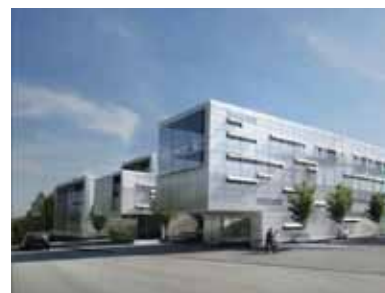
Nordea Livs nye kontorbygg på Kokstad i Bergen skal bygges på passivhusnivå. I prosjektet forenes god arkitektur med miljø- og energieffektive bygningsmessige og tekniske løsninger. Støtten fra Enova på 3,2 millioner kroner var utløsende for valget av passivhusstandard.
