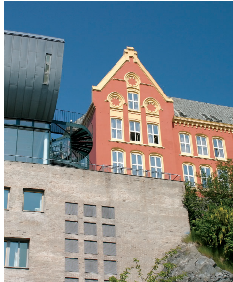
Forsidebildet er fra Jussbygget ved Universitetet i Bergen. Bygningen varmes med en sjøvannsvarmepumpe på 280kW. Sjøvannet fra fjorden gir i tillegg varme til blant annet BT-bygget, psykologi-bygget, Sydneshaugen skole (til høyre i bildet over) og HF-bygget. Prosjektet skal utvides slik at nesten alle større bygg på nordre Nygårdshøyden blir koblet på, deriblant muséene. Varmepumpeprosjektet ble i 1999 støttet av NVE gjennom Byggoperatøren og bygningen er også med i Bygningsnettverket.
