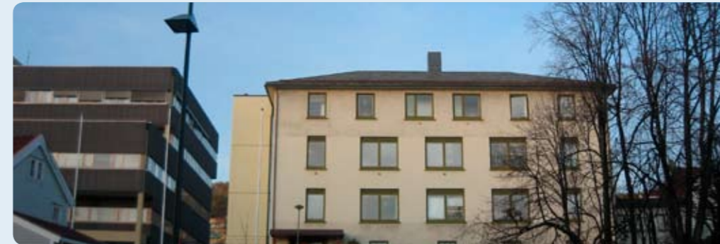
Møre og Romsdal fylkeskommunes administrasjonsbygg
