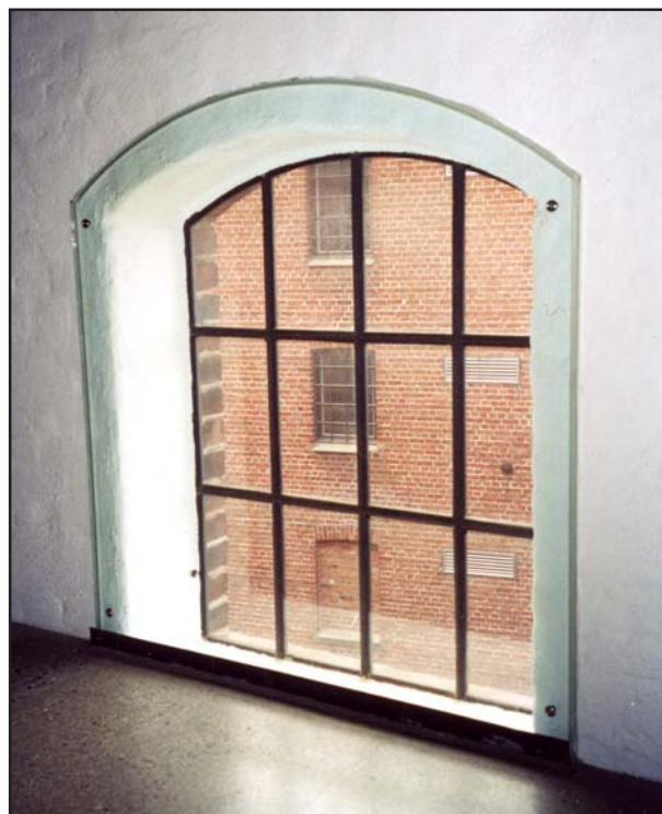
De gamle industribygningene ved Moss Aktiemølle har fått nye funksjoner, blant annet kino, bibliotek, industrimuseum m.m. De originale jernvinduene er bevart, men har fått et ekstra glass på innsiden. (Foto: E. Grytli)
