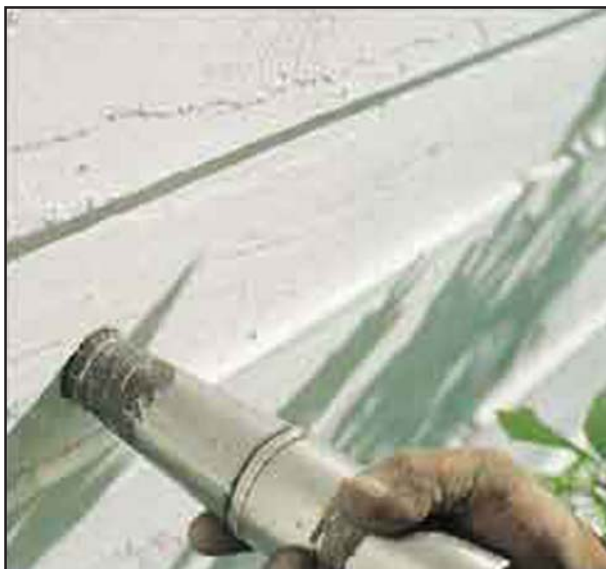
Innblåsing av isolasjon i vegg. (Foto: Enøkssentrene)
