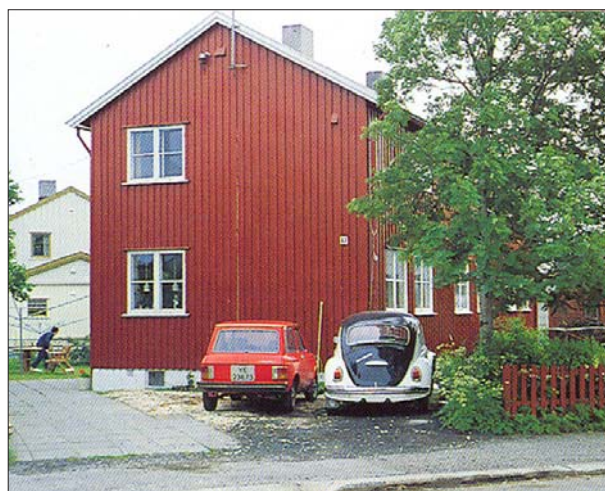
Svenskehus fra svenskebyen i Bodø. Husene ble bygget som elementhus basert på reisverkskonstruksjon (Foto: Brønne, Drange Aanensen: Gamle trehus)
