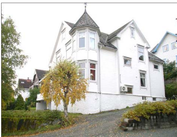
Eldre bolig med installert luft til luft varmepumpe. Plasseringen av det utvendige maskineriet kan virke skjemmende på fasaden. (Foto: W. Knudsen)
