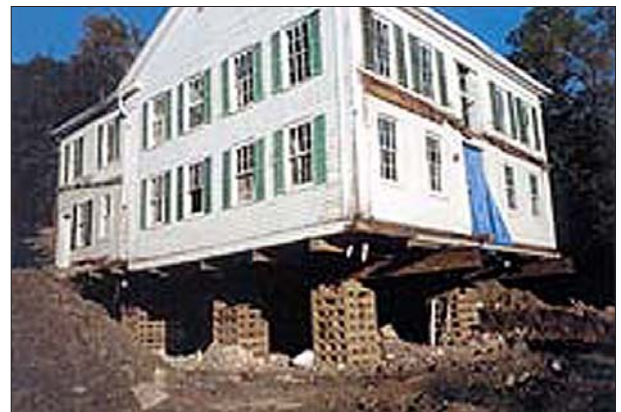
På grunn av store vannskader på fundamentet, måtte dette bygget fra 1847 løftes opp mens et nytt fundament ble konstruert. (Foto: The Arcola Mills Historic Foundation)
