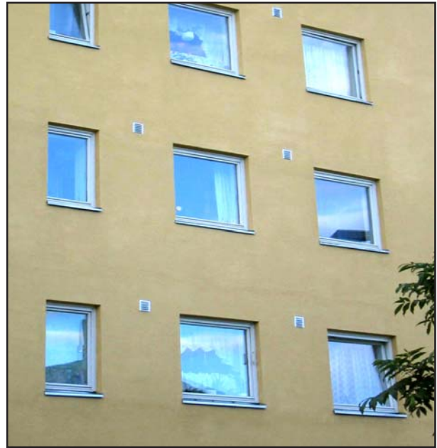
Bildene viser hvordan utvendig etterisolering av betonggård med teglsteinskledning kan endre bebyggelsens karakter. Rosenborg i Trondheim. (foto: W. Knudsen)
