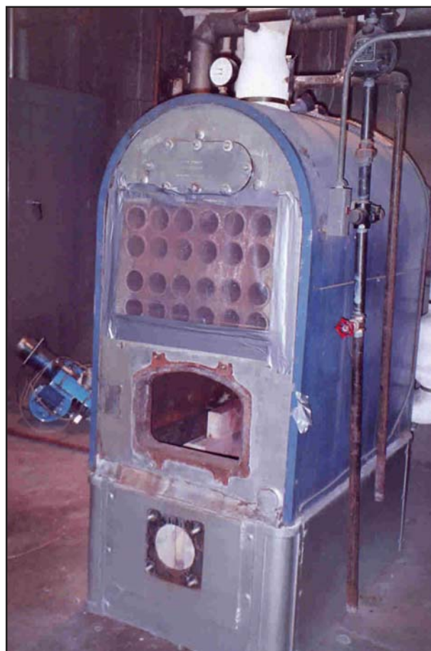
Gammel fyrkjel for et vannbårent varmesystem.
