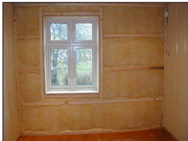
Med et lag isolasjon på plass er vegg klar til å få ny kledning. (Foto: Husbyggeren Norge)
