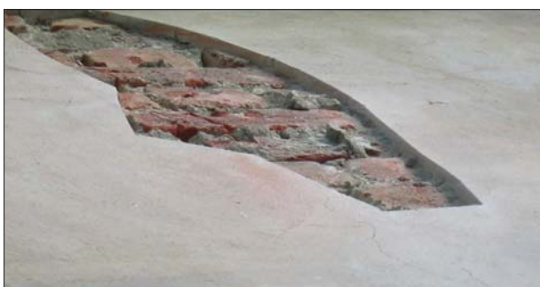
Gammel murgård under rehabilitering. Skader i pussjiktet er skåret bort. (Foto: W.Knudsen)
