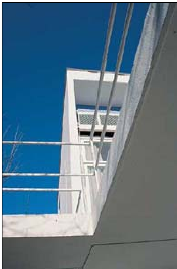
I de presise detaljene kommer husets eleganse frem. Den fine balansen mellom solid betong og minimalistisk detaljerte vinduer, rekkverk, dørhåndtak etc gjør det tunge stenhuset nesten vektløst. (Foto: Stenersenmuseet)
