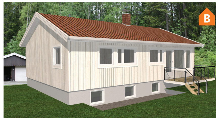
Moelven Senior, oppgradert til lavenerginivå
