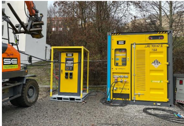
Figur 10 - Illustrasjon av battericontainer og mobil ladecontainer til pilotprosjektet for Napops hydrogenaggregat. Batteriet blir forsynt av strøm fra hydrogenaggregatet (som står et stykke unna). Bilde er hentet fra Hafslund mobile energiløsninger ( https://www.hafslundmobileenergi.no/utslippsfri-anleggsplass/ )
