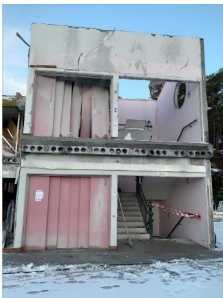
Figur 5.6 Hulldekker på Midtbygda sykehjem
